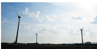
Der Ökostrom muss auch transportiert werden können. [Clemens Fabry]
